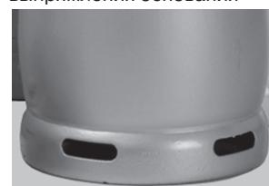
Рис. 3. Отремонтированное и покрашенное основание
